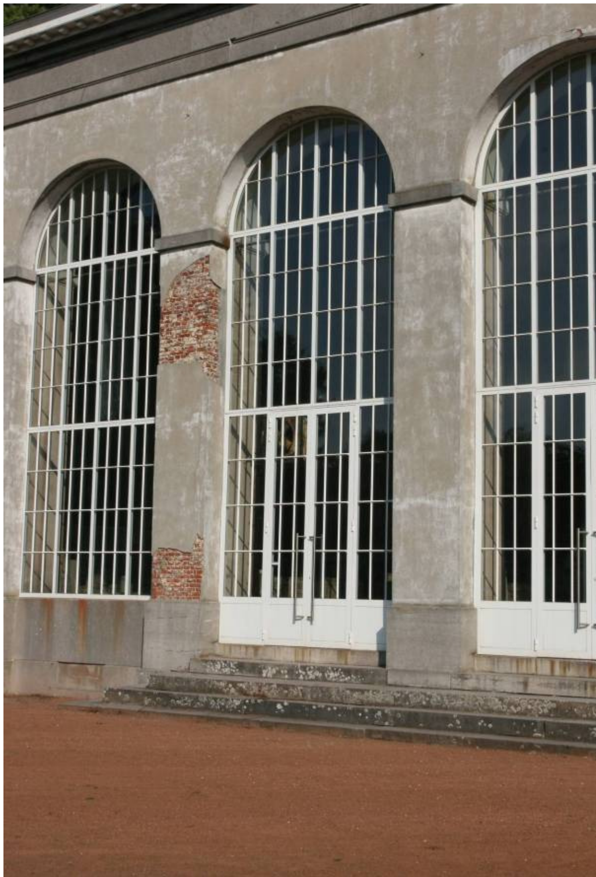
Fig. 4 : Jardin d'Hiver de Mariemont (Morlanwelz). Dislocation des enduits [Photo : M.D.].
